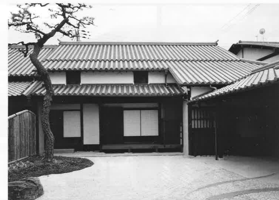
④旧新川家住宅。泉佐野ふるさと町屋館として活用、この地方特有の本瓦の綴(しころ)葺き屋根。修復再生
